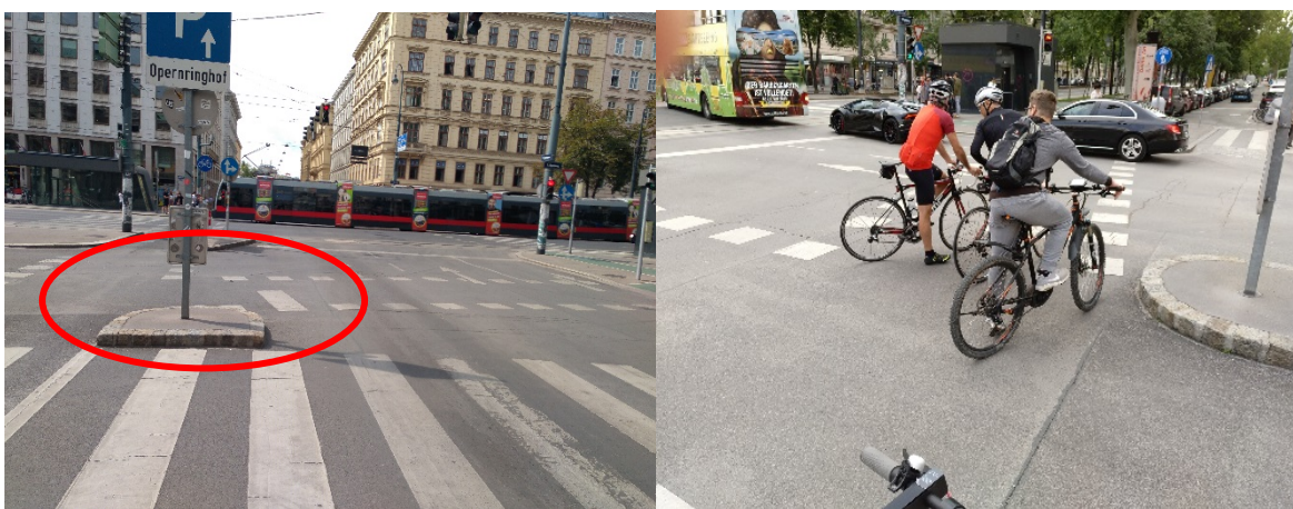
Abbildung 31: Größe der Aufstellfläche unzureichend
