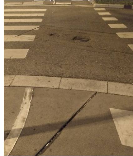
Abbildung 49: Unebenheiten im Kreuzungsbereich
